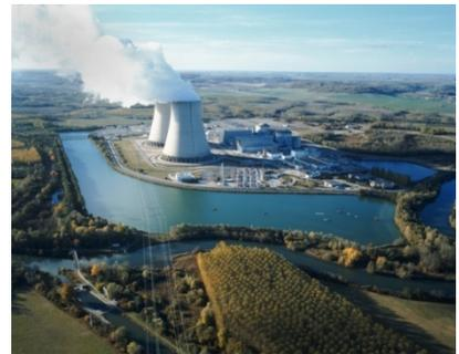
**Définition:** Le principe de fonctionnement d'une centrale nucléaire est d'utiliser la chaleur libérée par la fission de noyau d'uranium pour produire de la vapeur d'eau à haute pression qui, à son tour, actionne un groupe turbo-alternateur produisant de l'électricité.
