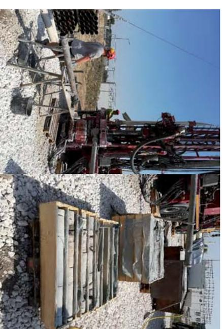
**Fig. 26. Réalisation du forage carottes**
